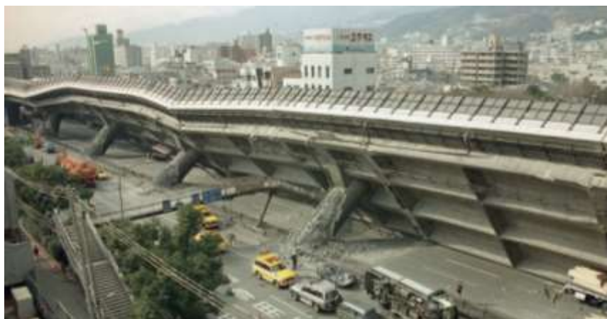
2 – rasm. Xyogo Nanbu prefekturasidagi zilzila vaqtida Xigishinada ko‘prikning shikastlanishi (Yaponiya, 1995 y)
